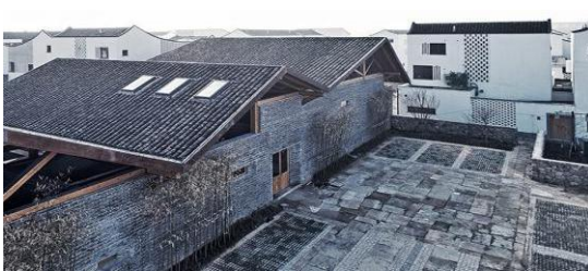
图 4-16 通过建筑的色彩、体量区别于村居，提高识别性 ( 图为杭州东梓关村村民活动中心 )
