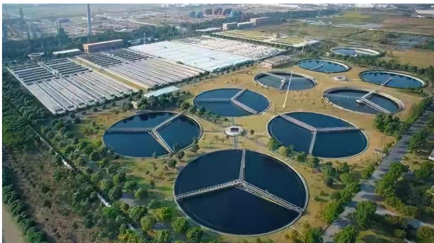
图 4-76 大型净化槽及光伏储能系统
