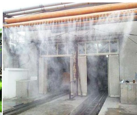
图 4-53 通过风幕、喷淋、除臭、吸附等措施，减少气味对周边环境的影响
