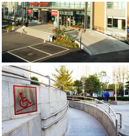
图 4-25 可在主入口设置回车坡道，便于救护车与主入口的衔接，规模较小的卫生站主入口设置残疾人坡道。
