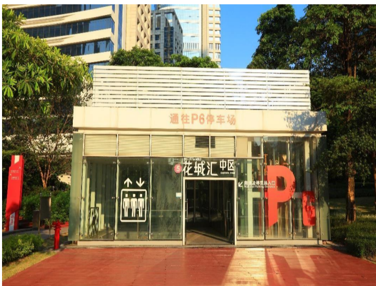
天河区花城广场通信基站
