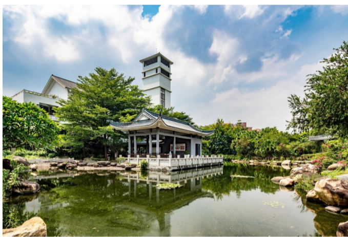
京溪地下净水厂
