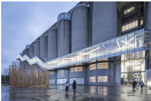
推荐示例：上海民生码头八万吨筒仓改造
